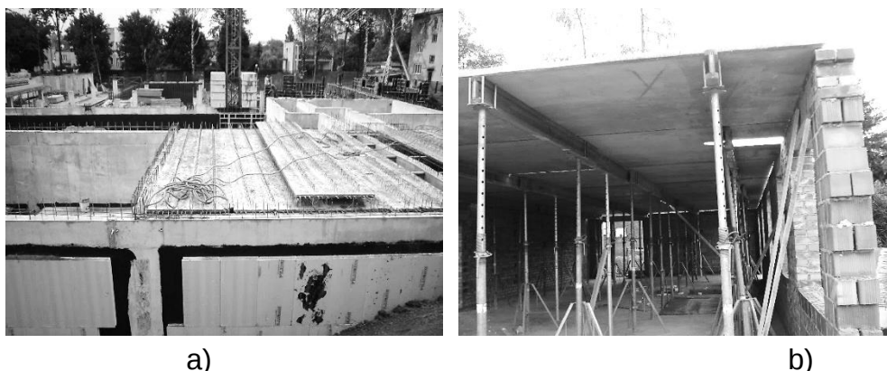
Rys. 24. Strop filigranowy: a) widok ogólny, b) sposób stemplowania [autor]
