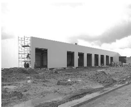
Rys. 20. Ściany z prefabrykowanej płyty warstwowej od strony zewnętrznej i wewnętrznej [autor]
