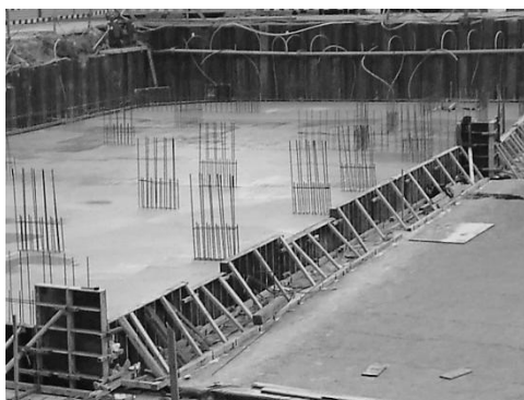
Rys. 9. Płyta fundamentowa – widoczne utrudnienie w wykonawstwie wynikające z zalewania wykopu przez wysoki poziom wody gruntowej, co spowodowało zastosowanie szczelnej ścianki i systemu odsączającego wodę [autor]
