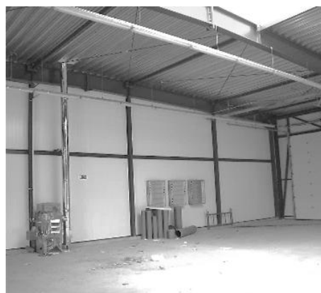
Rys. 20. Ściany z prefabrykowanej płyty warstwowej od strony zewnętrznej i wewnętrznej [autor]
