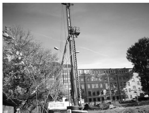
Rys. 11. Zwieńczenie pali płytą żelbetową i widok palownicy [autor]
