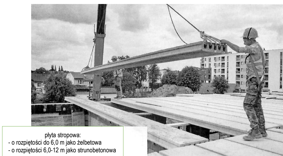
Rys. 25. Montaż stropu prefabrykowanego wielokanałowego [6]
