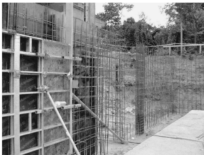
Rys. 14. Szalowanie ściany piwnicy łączonej do starterów dla zapewnienia monolitycznego zespolenia [autor]
