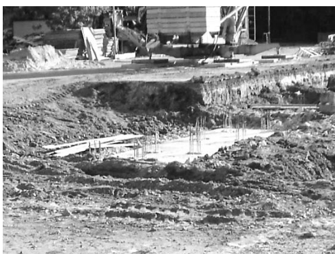
Rys. 11. Zwieńczenie pali płytą żelbetową i widok palownicy [autor]
