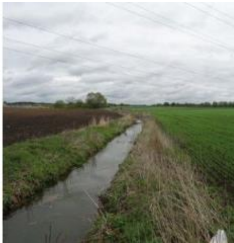
Rys. 6 Układ rowów melioracyjnych na polach: w wykopie - odwadniający (a), w nasypie – nawadniający (b) [ https://inzynieriasrodowiska.com.pl/ ]
