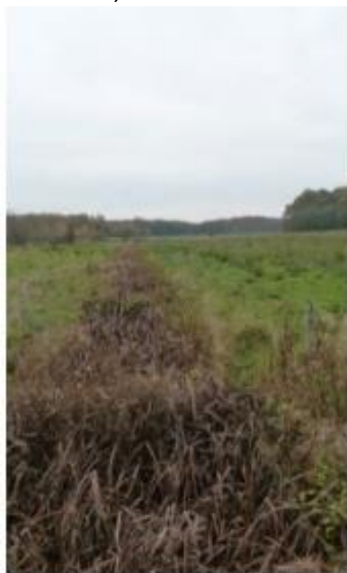
Rys. 7. Rowy melioracyjne - brak konserwacji [ https://inzynierbudownictwa.pl/ , https://kwidzyn.naszemiasto.pl/ ]
