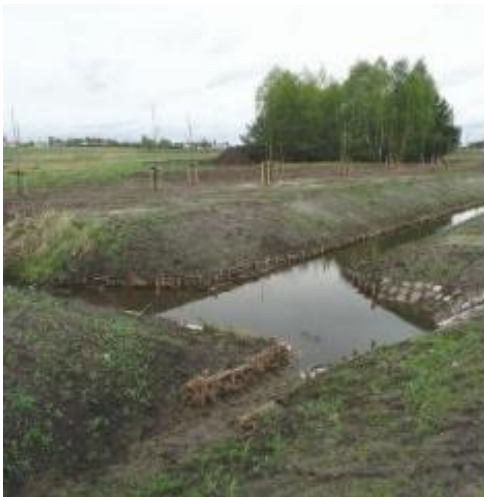
Rys. 6 Układ rowów melioracyjnych na polach: w wykopie - odwadniający (a), w nasypie – nawadniający (b) [ https://inzynieriasrodowiska.com.pl/ ]
