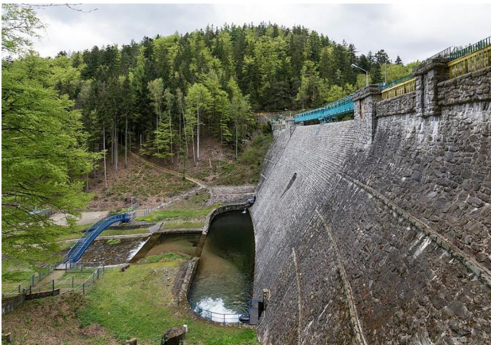
Rys. 11. Zapora wodna w Międzygórzu ( https://bibliotekanauki.pl ).
